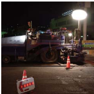
工事現場使用例
